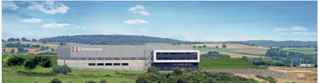
Компания построила в нынешнем году новый складской комплекс площадью 8000 кв. м со стеллажами 15-метровой высоты и парком автоматических штабелеров
