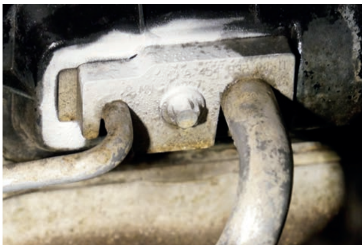
Наглядный пример обмерзания испарителя или воздухопроводов
