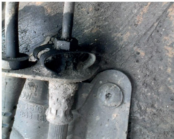
Ключом на 11 рассоединяем шланг и тормозную трубку. Нужно заглушить тормозную трубку от вытекания жидкости
